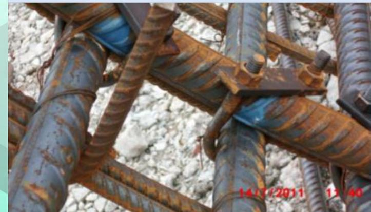
當用鐵線將鋼筋及金鋼圈定位後，
